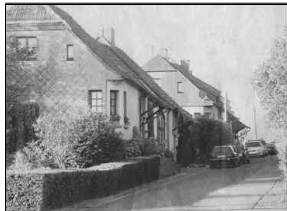
Doppelhaus in der Baltzstraße
